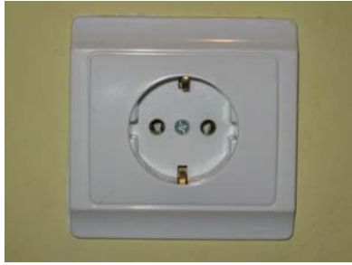
Contacto hembra bipolar con toma de tierra (base).
