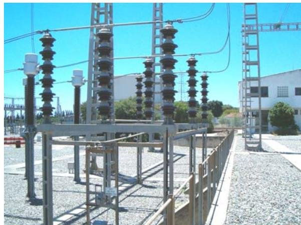
*Figura. Seccionador de tres columnas de 220 kV. El mecanismo es obvio: una cuchilla giratoria en la columna central.*
