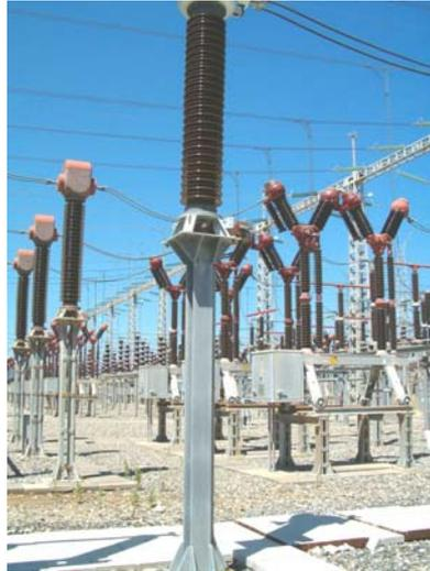
*Figura. Sobre una especie de carrito con ruedas está situado un **interruptor automático** 220 kV, poder de corte 35 kA. Las dos "V" son las cámaras de extinción del arco.*
