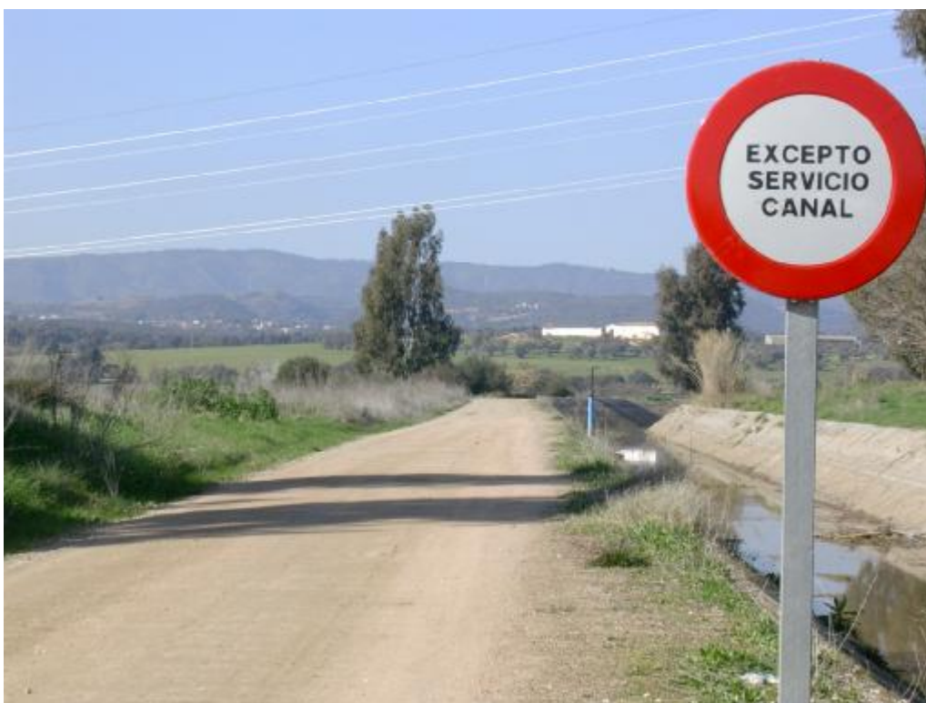
FOTO 12. Pista del canal del Guadalmellato en las inmediaciones de Rabanales.
