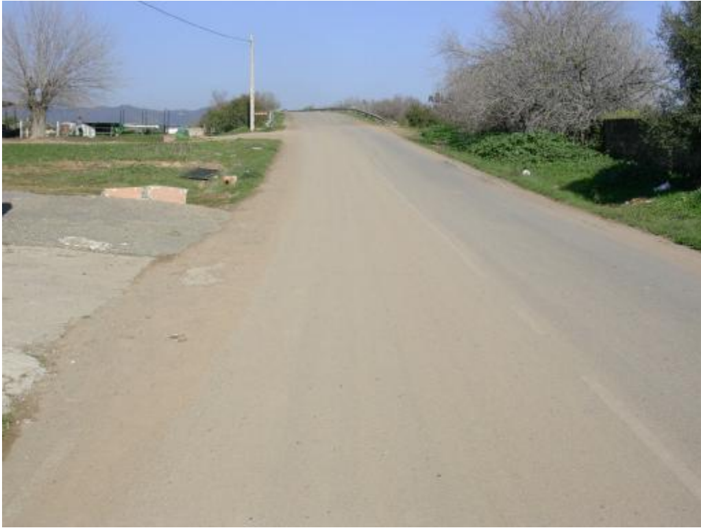
FOTO 6. Subida del viaducto.
