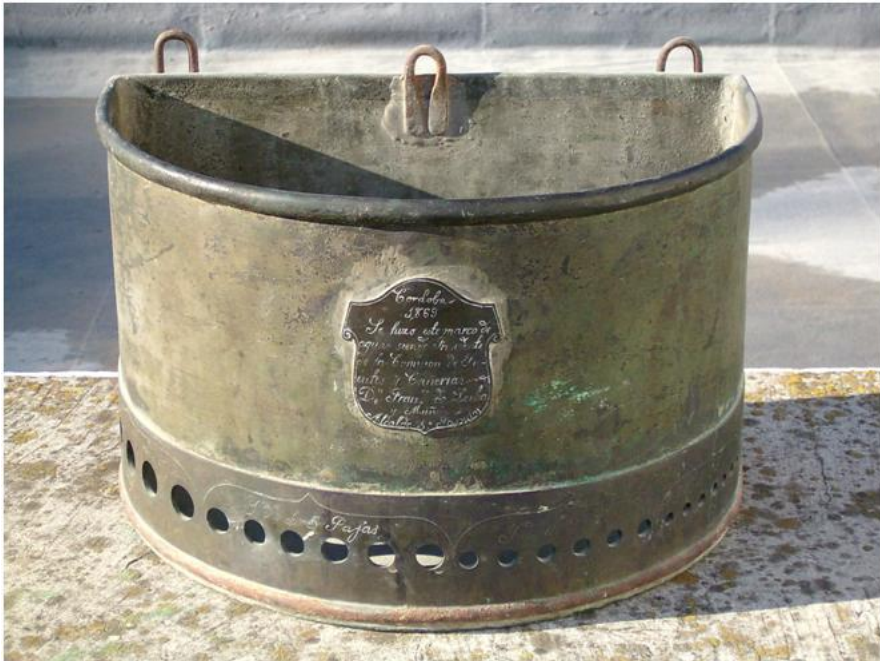
Figura 2. Arca de agua, o aforador, conservada en la Empresa Municipal de Aguas de Córdoba. Año de 1869 (Fuente: Pizarro Berengena, 2014).
