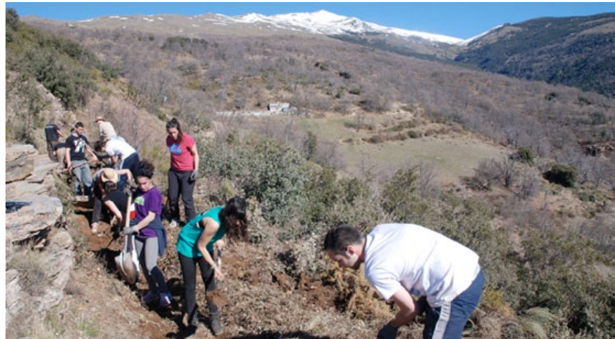
Recuperación de acequia
