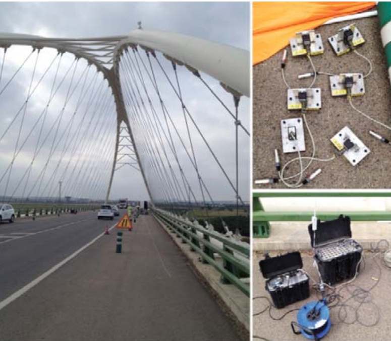
Foto 3. Campaña de medición experimental en el puente arco-atirantado de Palma del Río, Córdoba
