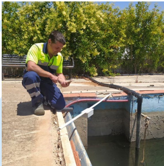
Un técnico comprueba uno de los sensores instalados en La Carlota
