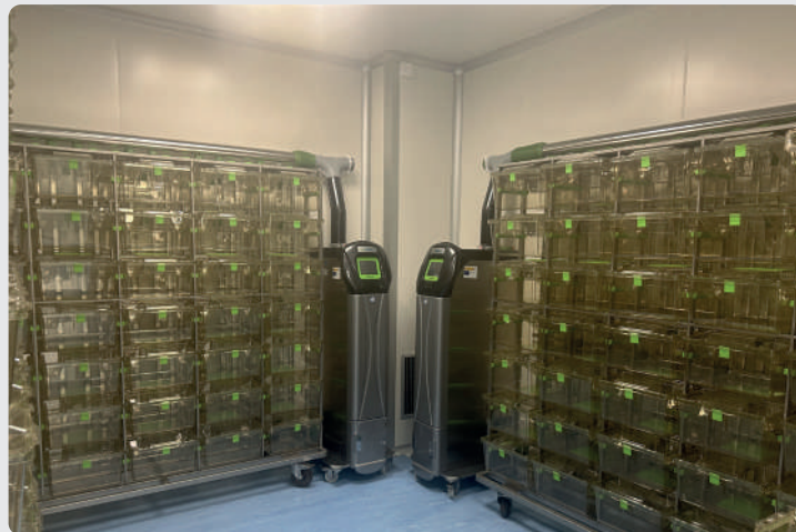
RACKS VENTILADOS PARA ESTABILACIÓN DE ROEDORES EN EL BIOMÓDULO EXPERIMENTAL BSL-2
